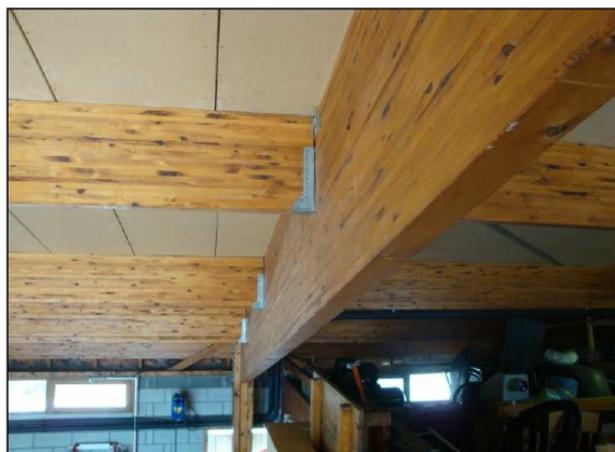
*Charpente lamellé-collé pins noirs/d'Alep/sylvestre
